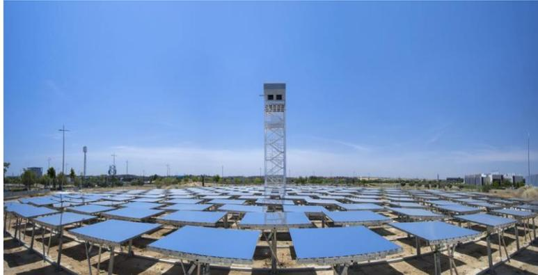
Abbildung 2: Solare Herstellung synthetischer Kraftstoffe für Luftfahrt – Projekt SUN-to-Liquid (Quelle: DLR)
